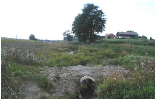
Danach: Strukturreicher Bach durch flächigen Vorlandabtrag. Die Überfahrt dient als „Hochwasserbremse“ (Bauabschnitt III). (Foto: T. Hofmann)
