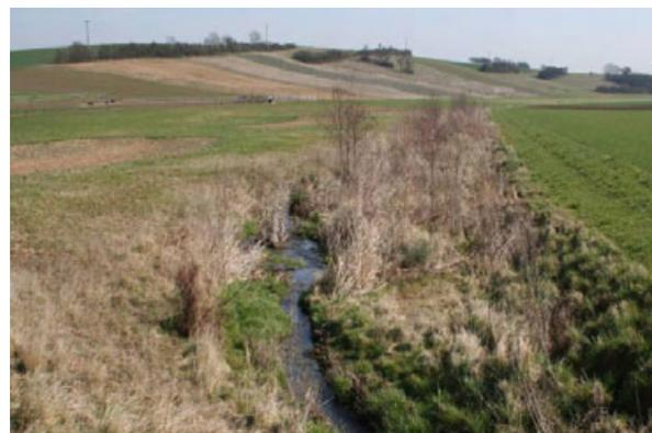
Renaturierter Bereich: Die Modellierung erfolgte nach fachlicher Einweisung durch einen versierten Baggerfahrer. Der Feinschliff lag in der Hand des Gewässers selbst. Abgesteckt wurde nur die Gewässertrasse. (Fotos links: N. Schneider, Foto rechts: R. Schoberer)
