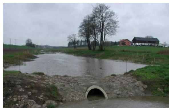
Danach: Hochwasserrückhalt in der Fläche auf ca. 4.000 m<sup>2</sup>! (Bauabschnitt III). (Foto: T. Hofmann)
