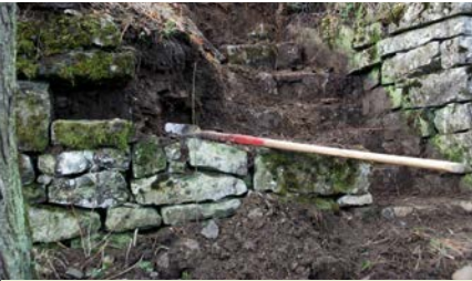
Beim Bau der Trockenmauer
